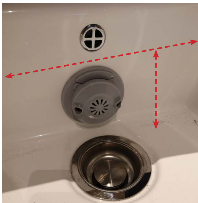
A. Le niveau de l'eau doit TOUJOURS COUVRIR le moteur hydro massage
