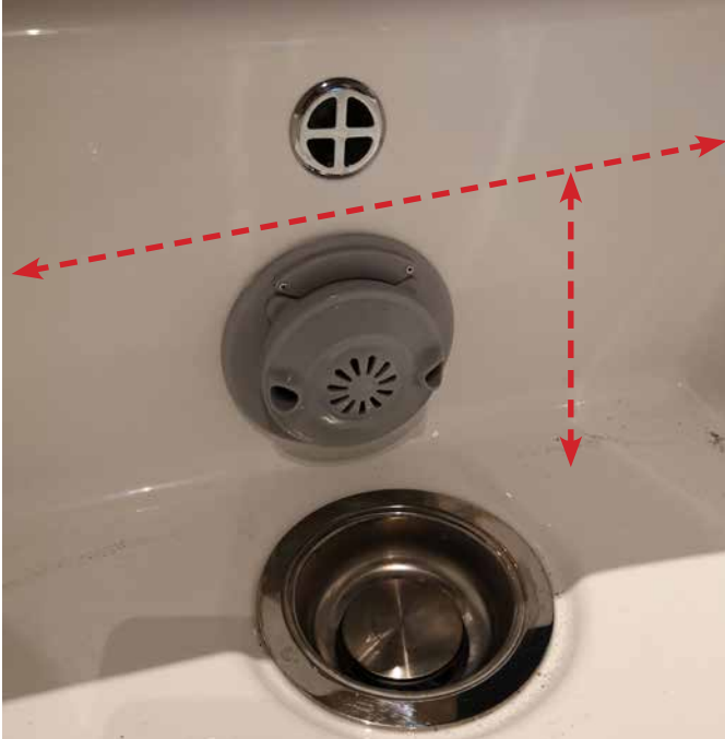
A. Der Wasserstand MUSS IMMER DEN HYDROMASSAGE MAGNA JET ABDECKEN
