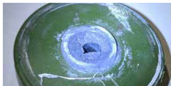
C. Condizione della girante rovinata per RIEMPIMENTO PARZIALE
