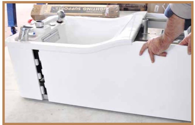
SCHRITT 4: Entfernen Sie die linke seitliche Holzabdeckung
