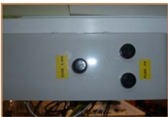
Figura 1 – Fusibile Cromo (3.15A) e Scheda Elettronica (4A)
